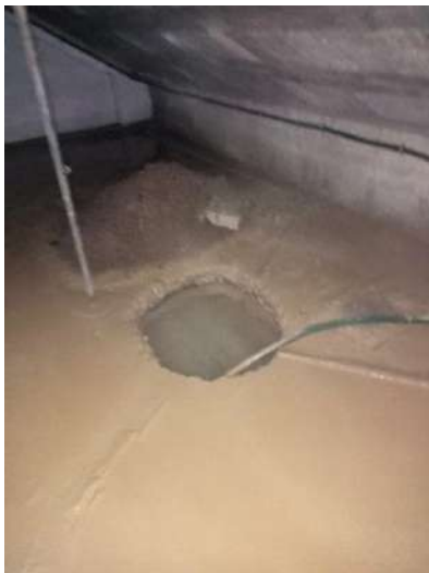
fotos – vista pelo interior do alçado poente – nível freático elevado, infiltrações e existência de um poço antigo
