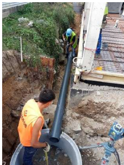
fotos – abertura de caboucos para execução de rede de águas pluviais pelo exterior
