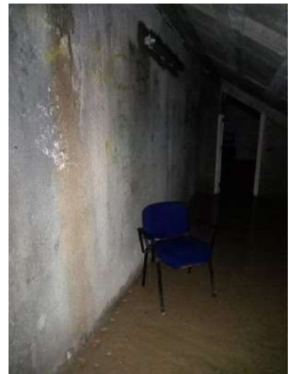
fotos – vista pelo interior do alçado poente – nível freático elevado, infiltrações e existência de um poço antigo
