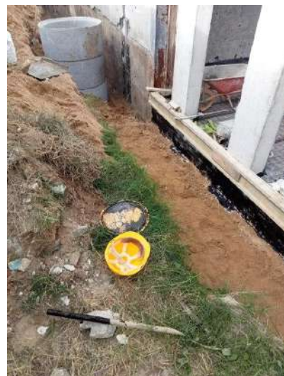
fotos – abertura de caboucos para execução de rede de águas pluviais pelo exterior
