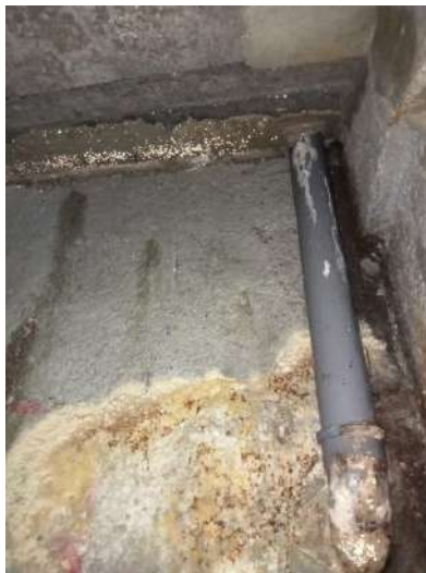
fotos – vista pelo interior do alçado poente – nível freático elevado, infiltrações e existência de um poço antigo
